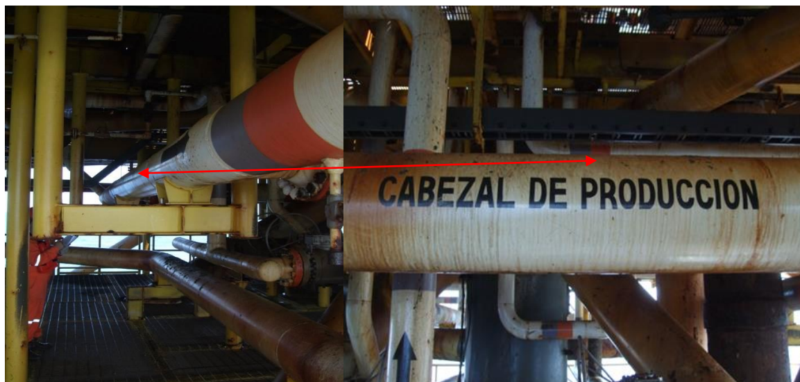
Fig. 2 Cabezal general de producción 14", punto de interconexión con Hot Taping.
